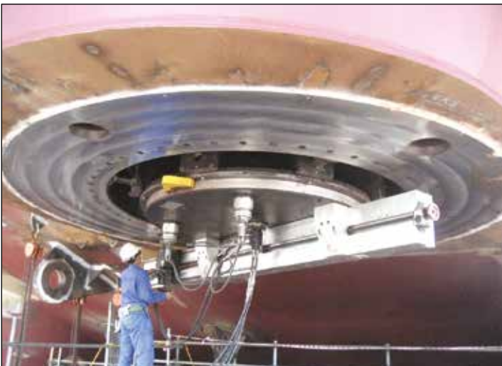
▼ Фрезерование фланца судового подруливающего устройства.
