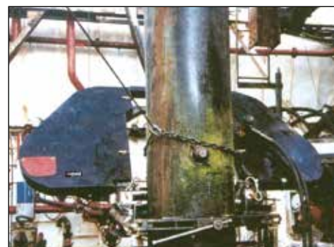
▼ Работы по демонтажу с использованием ленточной пилы.
