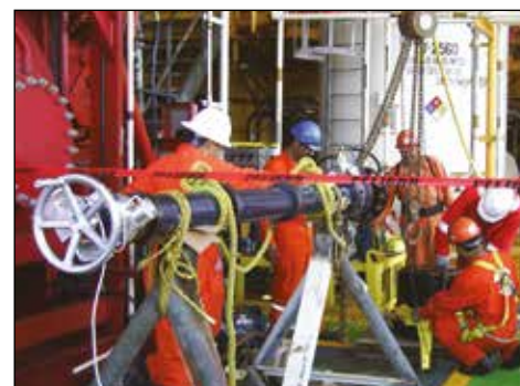
▼ Горячая резка с помощью СНТ2000 при выполнении работ на морской платформе.
