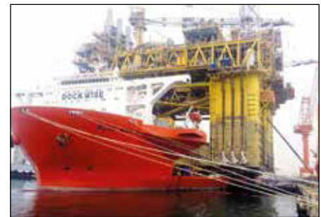
Синхронный монтаж конструкций и спуск их на воду
