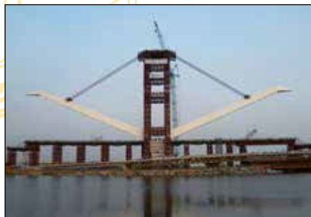
Удерживание и перемещение тяжелых конструкций с высокой точностью
