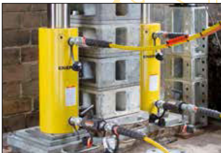
Подъем и установка мостов
